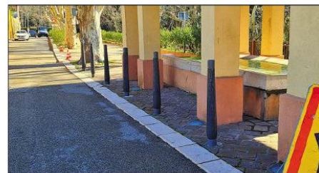
Durant les travaux, la circulation ne sera pas interrompue, sauf une journée pour l'arrivée de la passerelle acheminée par convoi exceptionnel. (Photo C. S.)
